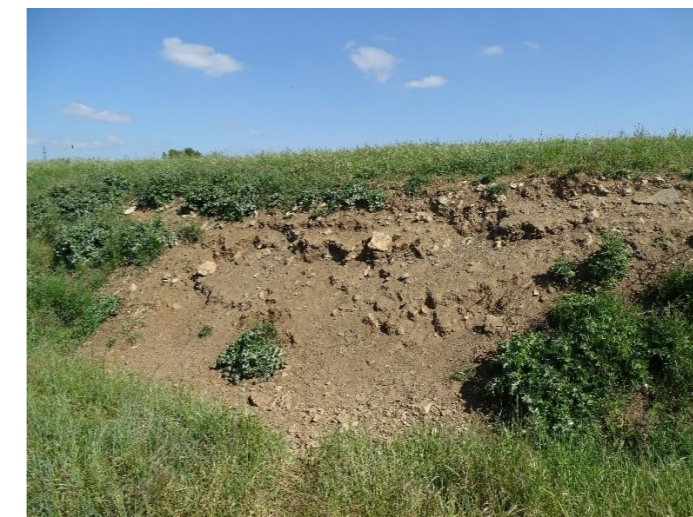
Figure n°21 : Erosion au nord du bassin, sur la ZIP
