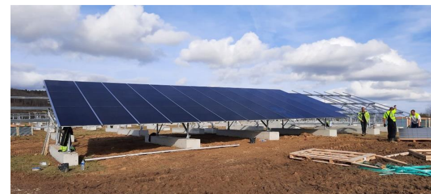
Exemples de mise en place de panneaux sur les chantiers URBASOLAR de Clarac (31)
