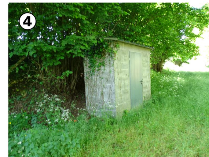
Vue sur le local, au sud-est de la ZIP
