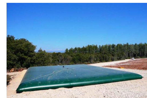
Exemple de citerne incendie (source : Urbasolar)
