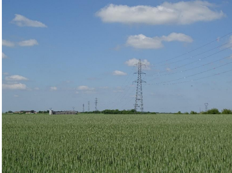
Photo n°19 : Ligne à haute tension au sein de l'aire d'étude paysagère intermédiaire
