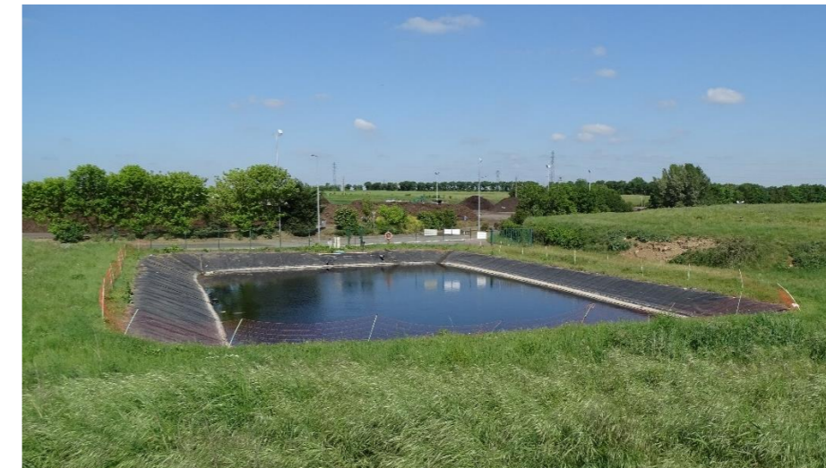
Photo n°3 : Bassin de récupération localisé en partie ouest/sud-ouest de la ZIP
