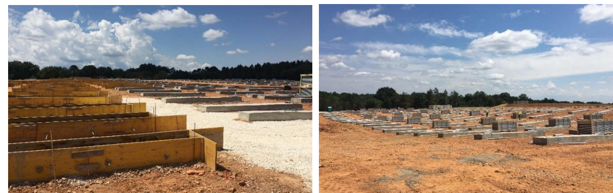
Exemples d'utilisation de longrines béton sur les chantiers URBASOLAR de La Chapelle Gonaguet (24)
